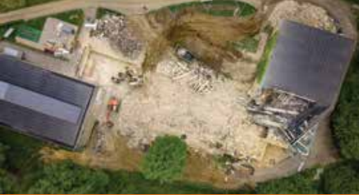
Construction de la nouvelle piscine du Joli-Bois
