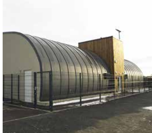
De nouvelles installations à la RESA Aubange
