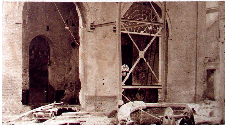
La destruction des hauts-fourneaux d'Halanz : Un bâtiment de machines soufflantes entièrement vidé de son outillage.
