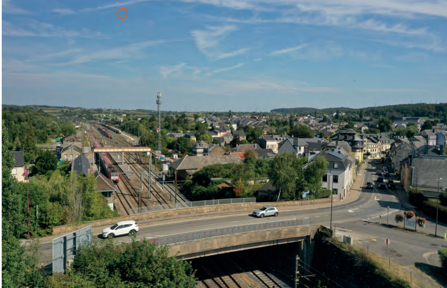
La gare d'Athus et son pont enjambant les voies
