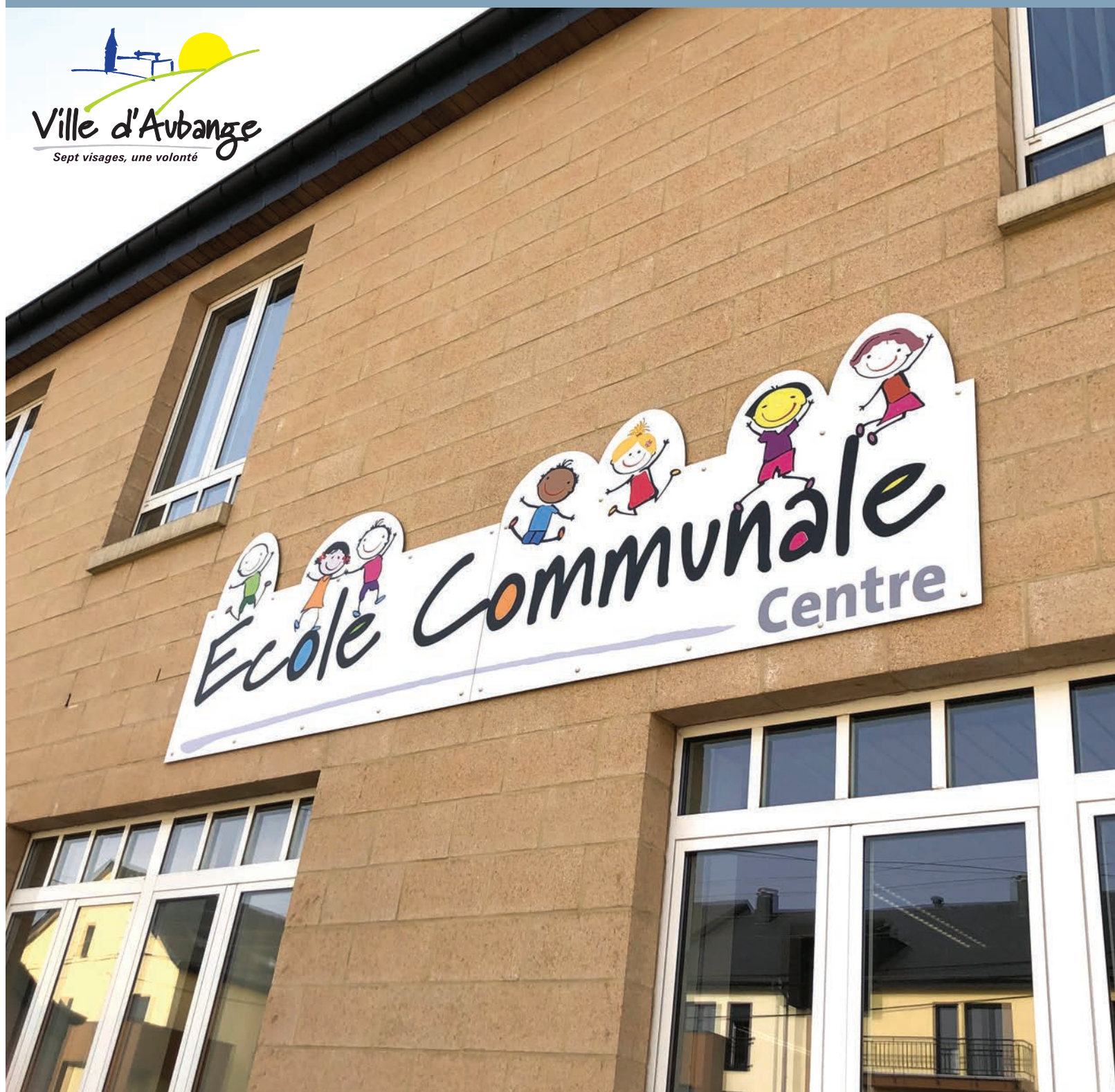
Travaux de rénovation à l'école communale d'Aubange p.17
