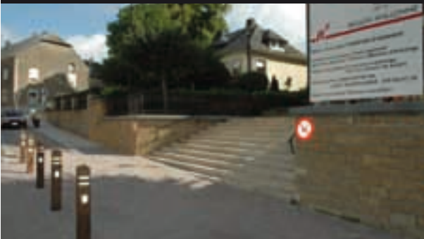
Aménagement des rues Bosseler, Hansel et Burton à Aubange
